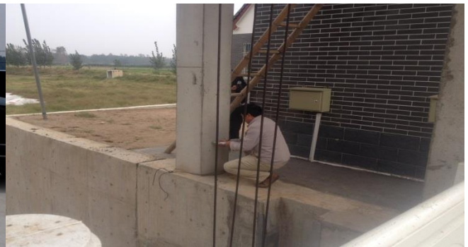
小店节制闸上游排架柱混凝土强度检测
