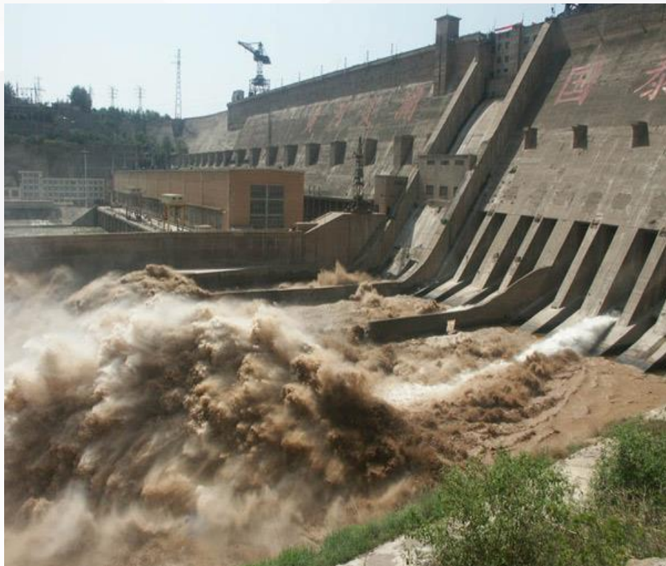
三门峡实体重力坝
